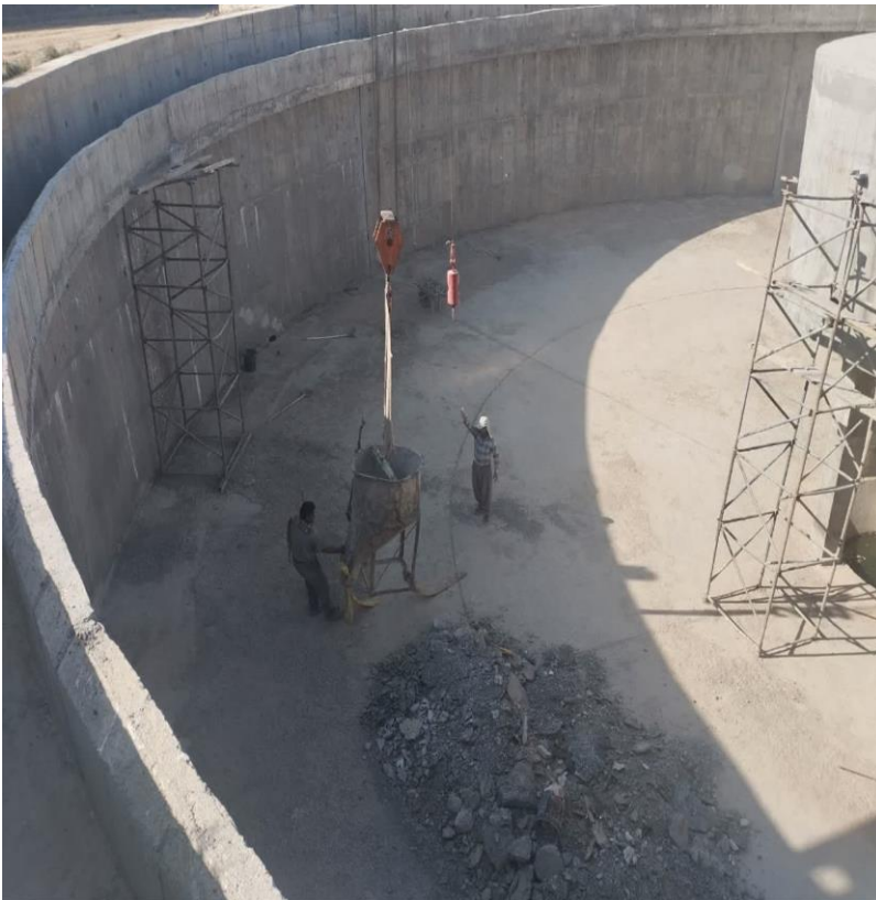
پاکسازی سازه های تصفیه خانه فاضلاب
