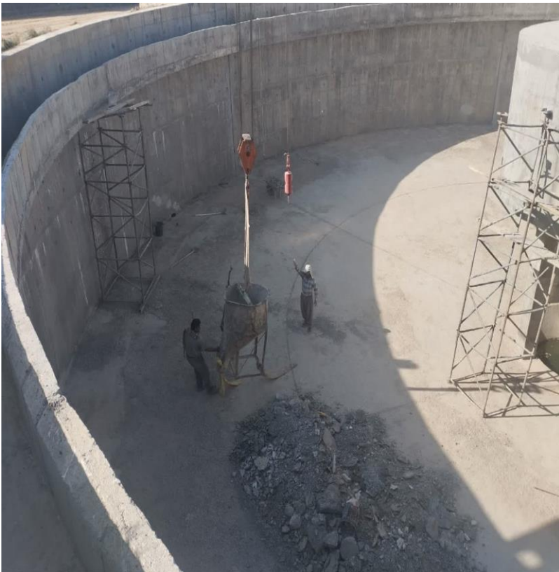
پاکسازی سازه های تصفیه خانه فاضلاب
