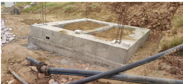
احداث فونداسیون اتاقک تاسیسات
