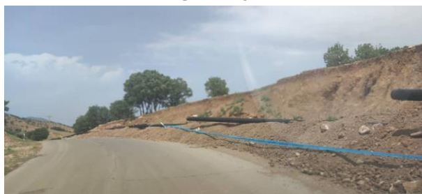
استقرار لوله ها در امتداد مسیر
