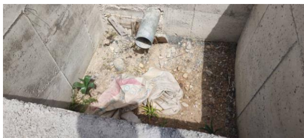
ساخت مخزن با حجم ۱۰۰ و ۲۰۰ مترمکعب
