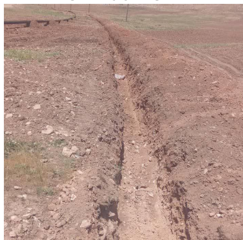
عملیات حفاری کانال لوله فلزی ۳۰۰
