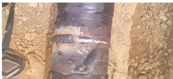
جوشکاری لوله ها
