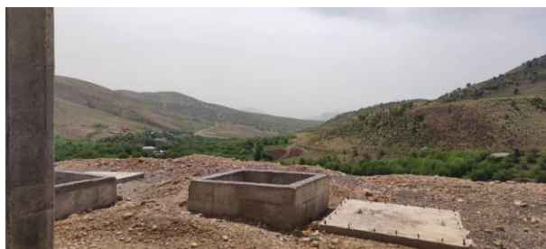
ساخت مخزن با حجم ۱۰۰ و ۲۰۰ مترمکعب
