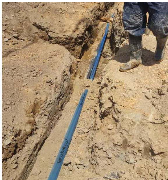
اجرای نوار اخطار
