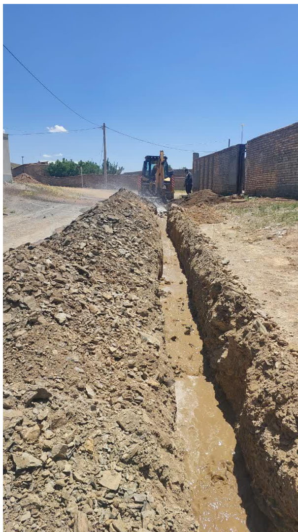
حفاری کانال با عمق و عرض مناسب
