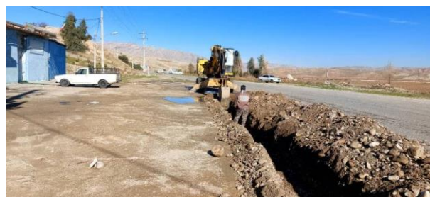
حفاری مسیر لوله گذاری
